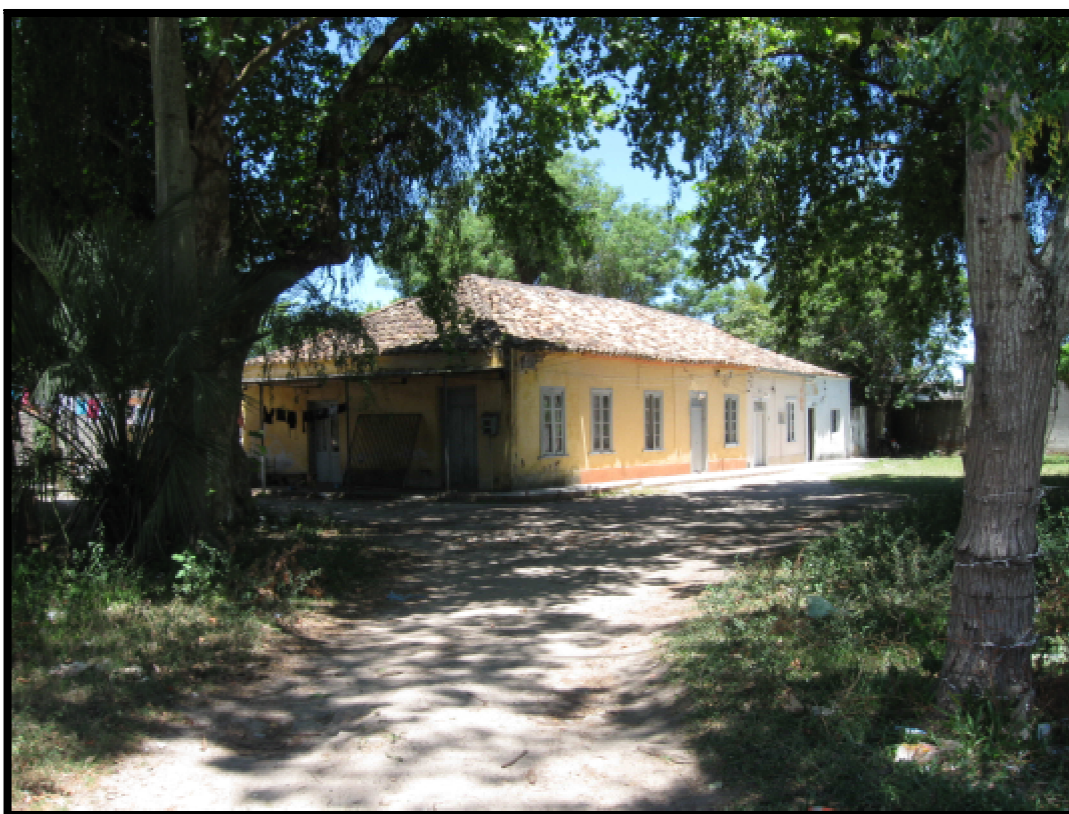
Figura 61 – Prédio principal localizado à rua Barão de Santa Tecla. Fonte: Foto da autora, 2010.
