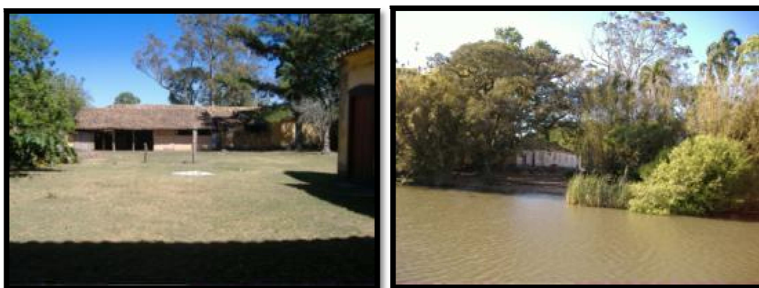
Figuras 43 e 44 – Pátio interno e prédios anexos da charqueada Barão do Jarau. Fonte: Banco de dados do LÂMINA, 2010.
