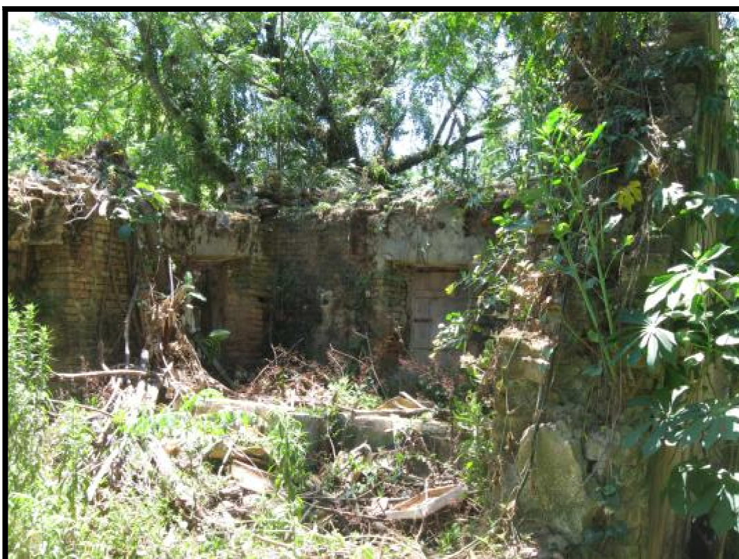
Figura 63 - Prédio dos fundos (Vista interna). Fonte: Foto da autora, 2010.
