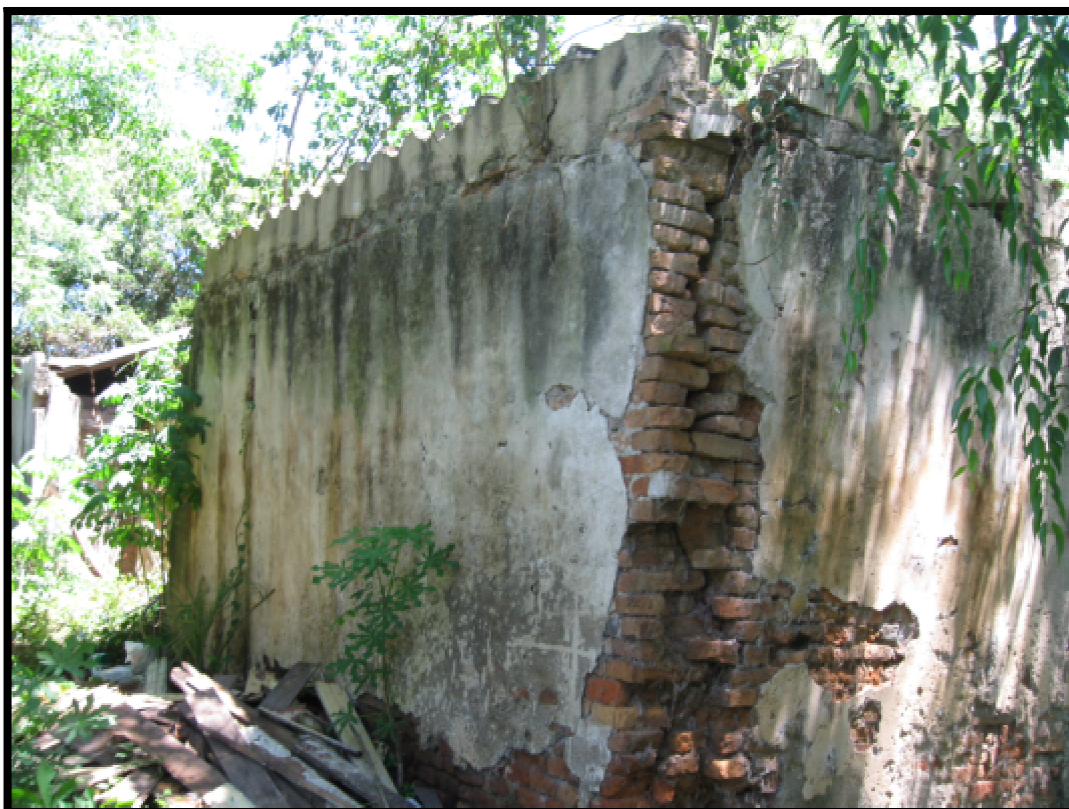
Figura 62 – Prédio dos fundos (vista externa). Fonte: Foto da autora, 2010.
