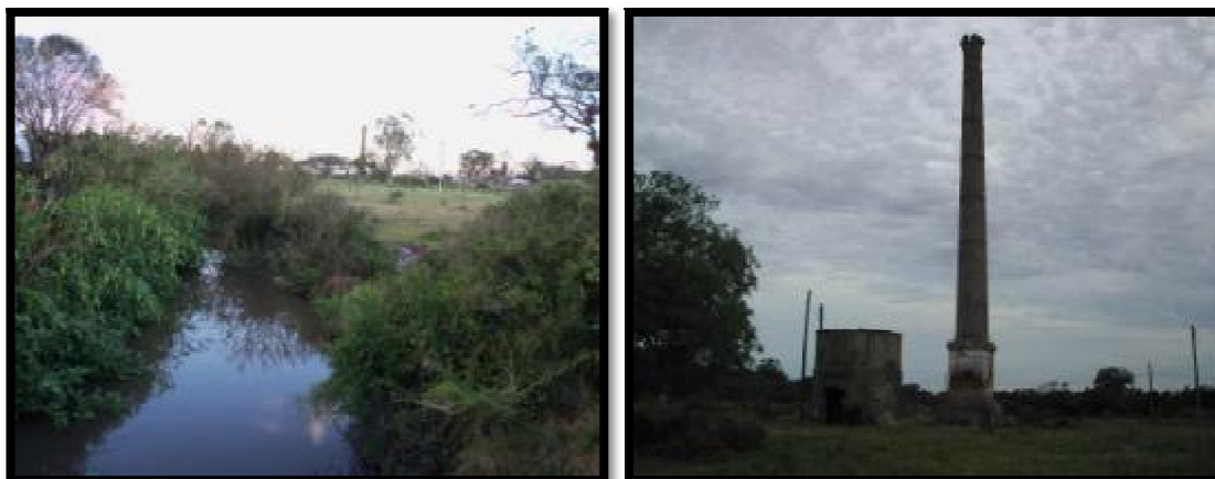
Figuras 11 e 12 - Sanga que faz divisa com a propriedade; estruturas da área de produção. Fonte: Fotos da autora, 2010.
