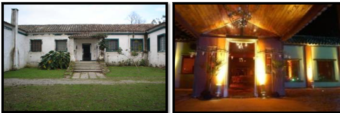
Figuras 25 e 26: Modificações na fachada dos fundos da sede. Fonte: (20) Foto de Cíntia Essinger, 2006 (Pelotas, historia_do_charque s.d.); (21) https://fbcdn-sphotos-a.akamaihd.net/hphotos-ak-snc7
