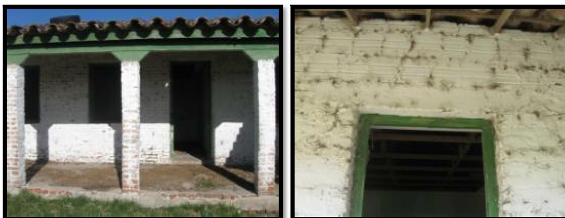
Figuras 54 e 55 – Detalhes da fachada da edificação evidenciando a mistura de elementos construtivos antigos e modernos. Fonte: Fotos da autora, 2011.
